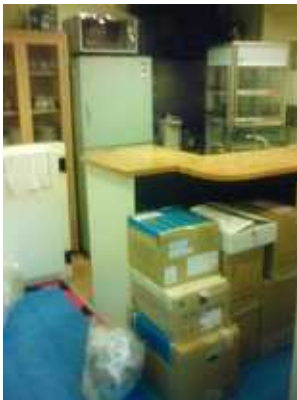
あり得ないくらいの突貫工事中!
